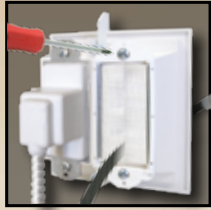
Décor Straps Install From Behind
